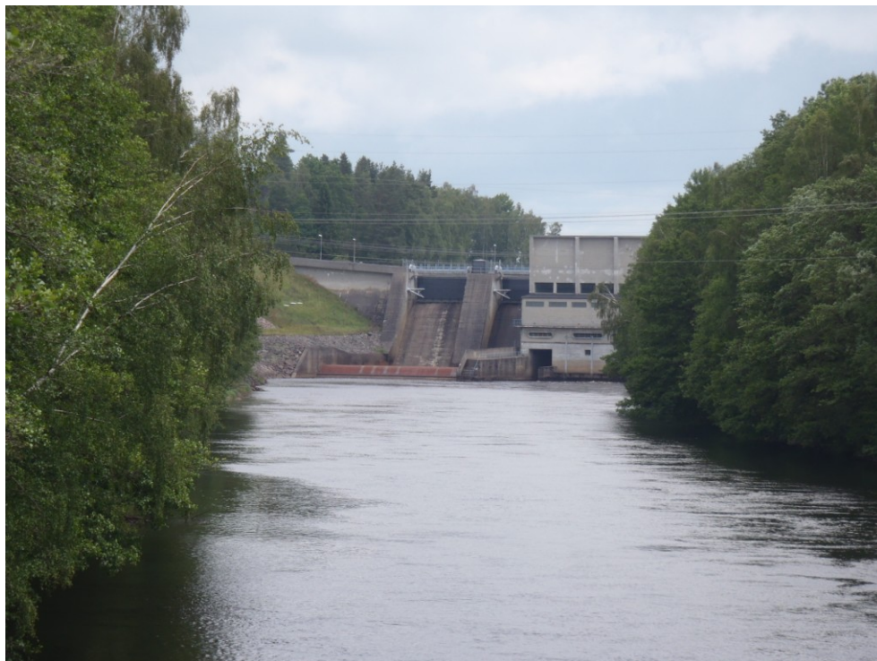
Lagan, nedströms Trarydsmagasinet - 18
